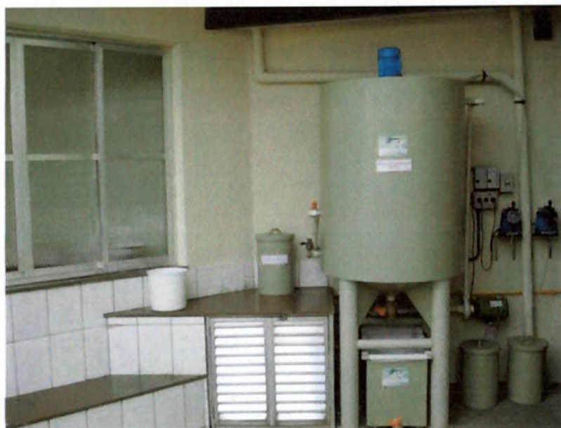
Figura 6 – Exemplo de sistema de tratamento interno de RSS (ETE) em uma clínica particular.
